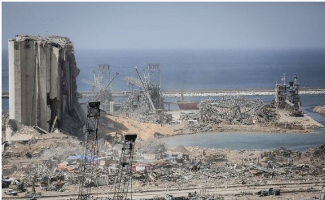
Le port de Beyrouth après la double explosion, Wikipédia, 2020
